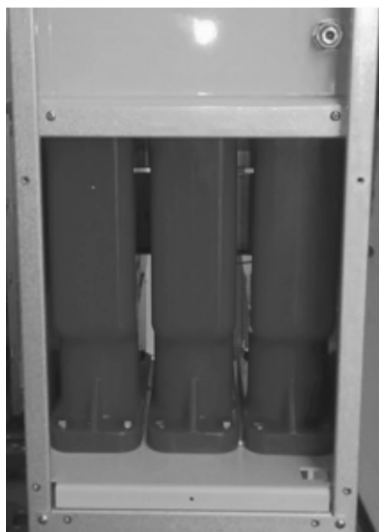
图 2 C 柜、V 柜环氧浇注模块局部外观示意图
